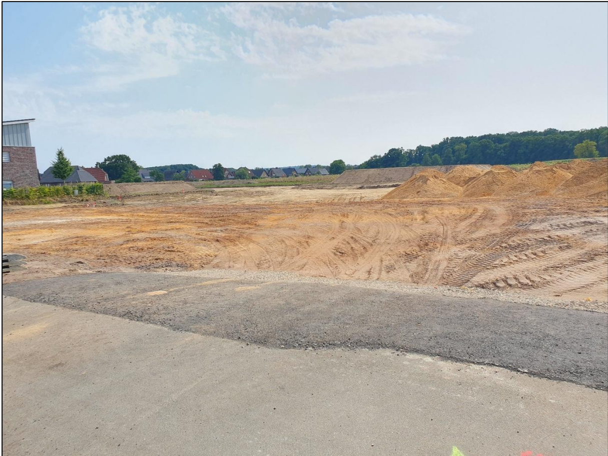
Abbildung 7: Plangebiet von der Weseker Straße, Blickrichtung Südosten, Wohngebiet Bogterkamp im Hintergrund
